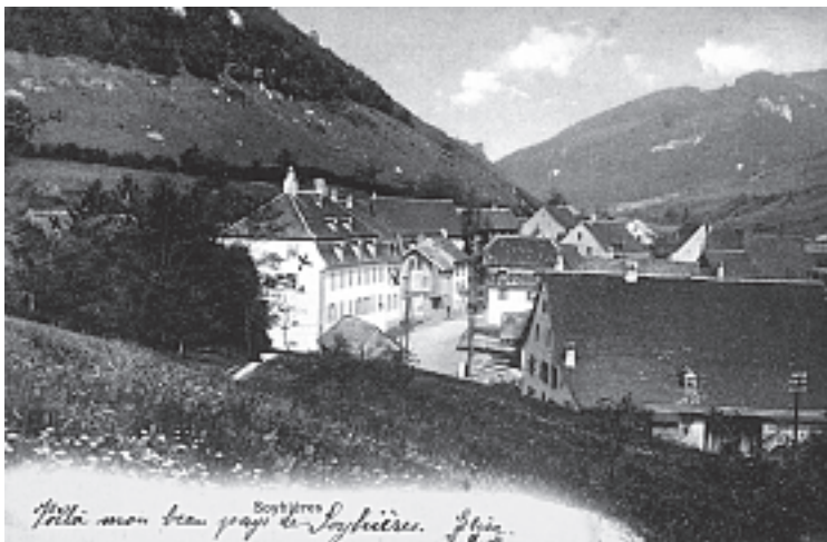
Foto: Maison Chappuis in Soyhières, 1909 (Archiv Stefan Keller)
