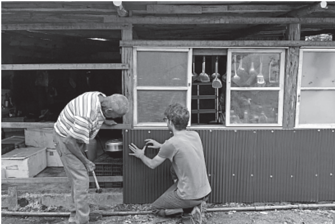
Unterstützung bei einem Neubau in den Bergen.
