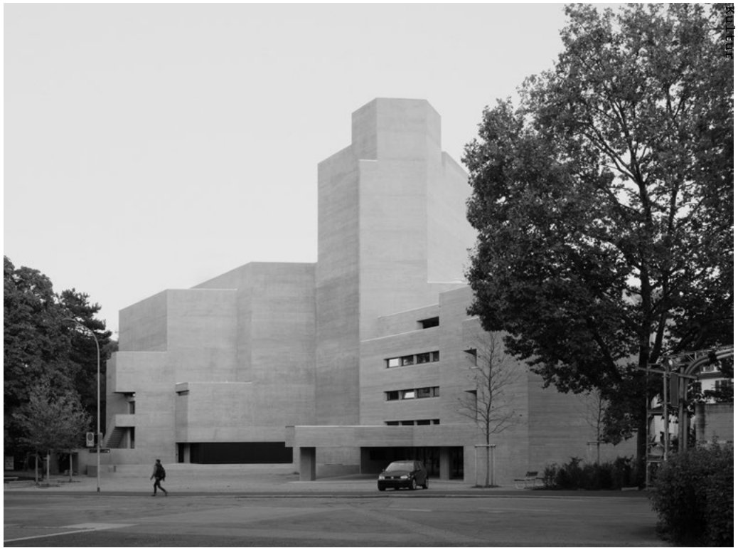
Der Sichtbeton wurde relativ zurückhaltend bearbeitet. Der Poren-Lunker-Verschuss wurde abgetragen, schadhafte Stellen darunter lediglich repariert. Um dem gesamten Bau ein möglichst einheitliches Bild zu geben, behandelte man die Erweiterung anschliessend mit einer Lasur aus Steinmehl.
